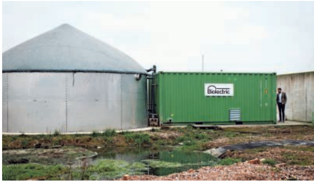
De biogascentrales van Bioelectric zetten mest om in elektriciteit. © SISKI VANDECASTEELE
